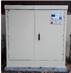
Le **NRO (Nœud de raccordement optique)**, d'où le signal arrive et d'où il repart vers toutes les armoires de rue.
