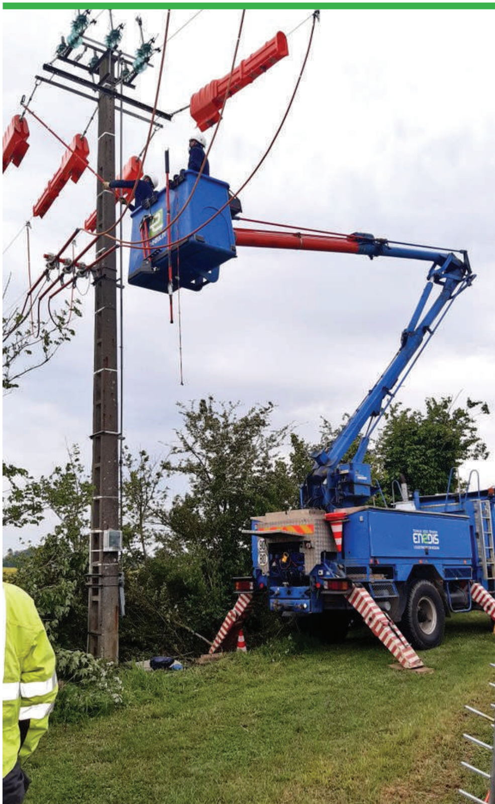
Intervention sous tension dans l'Aisne
