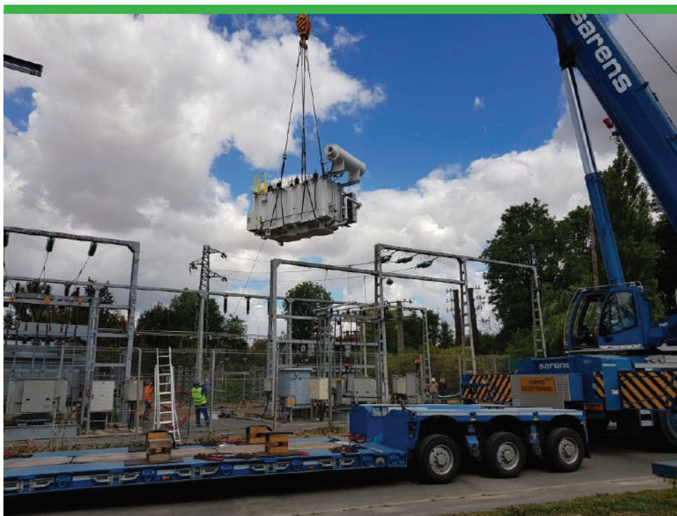
Pose d'un nouveau transformateur au poste source de Noyales
